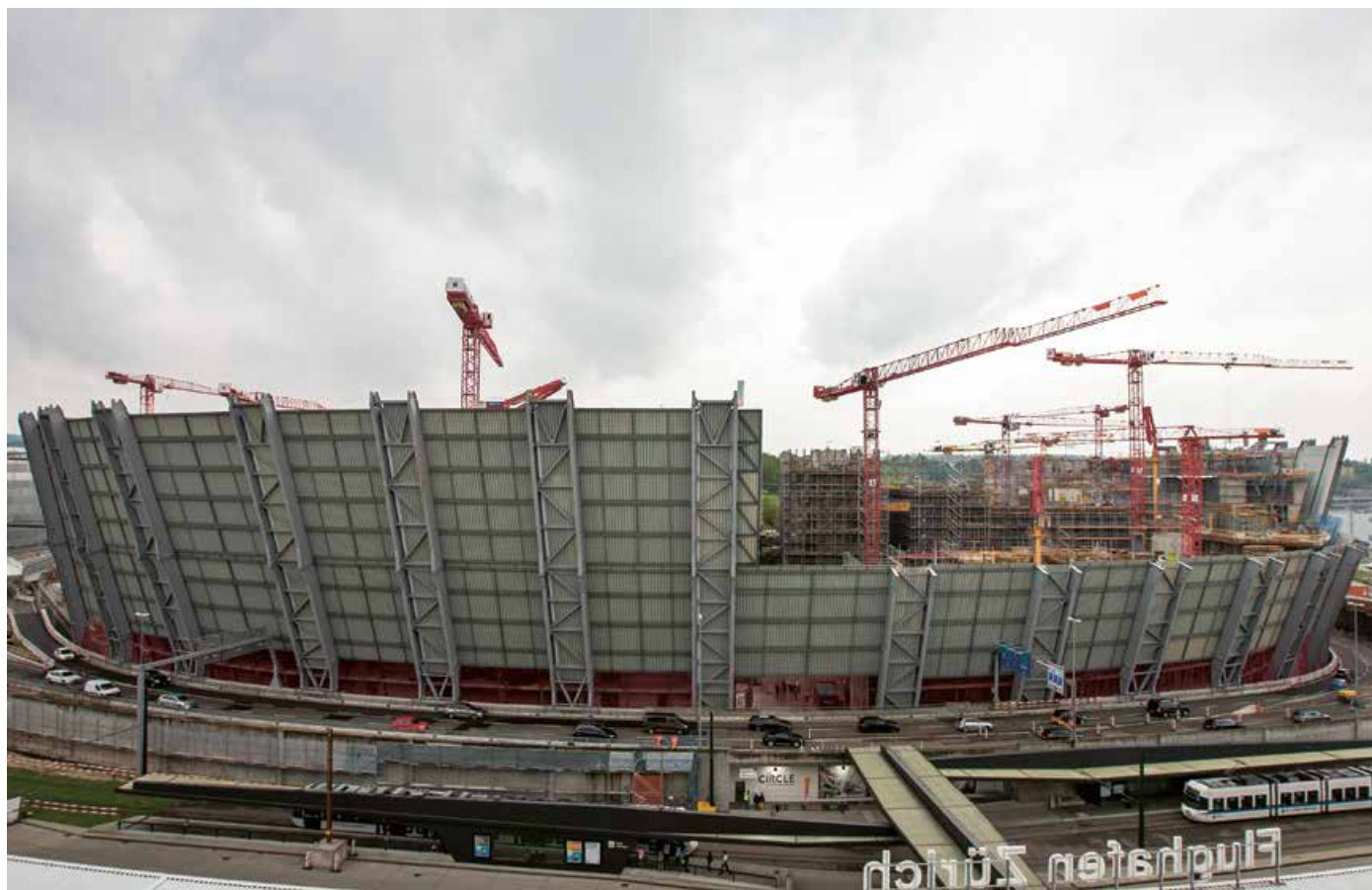
Chantier de «The Circle» à l'aéroport de Zurich | Keystone/Alexandra Wey
